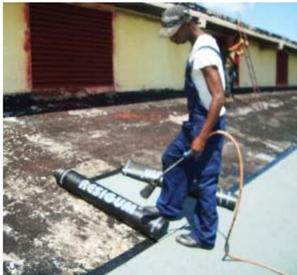
Almacén Bucanero colocación de la manta asfáltica RESIGUM TL 5 kg.
