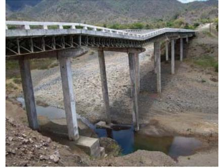
Asentamiento provocado por socavación en el puente Magdalena debido a la obstrucción parcial del cauce y enorme velocidad del agua.
