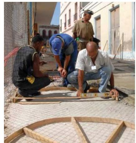
Pavimentación de la calle Maceo. Constructores preparan el diseño que se realizó en granito y mármol.
