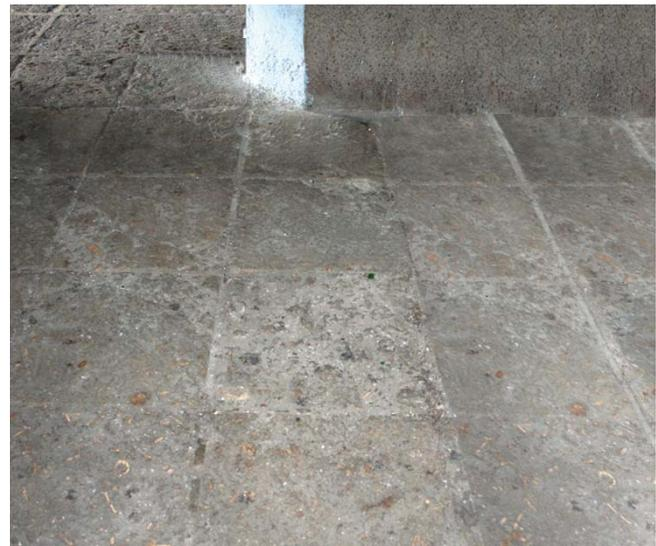
Detalle de un paso y plazoleta pavimentados en piedra jaimanita erosionados en una edificación de alto valor histórico cercana a la costa con importantes deposiciones salinas en oquedades. A la derecha: acumulación de polvo y lodo en el pavimento interior del restaurante.
