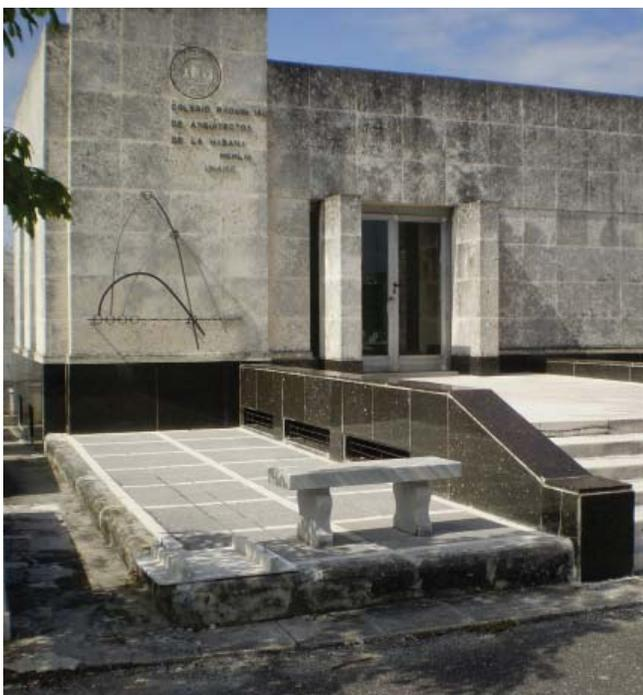
Ejemplos de obras enchapadas en piedra jaimanita colonizadas por microorganismos y degradadas por deposiciones de contaminantes de la atmósfera. A la izquierda: el Panteón de la UNAICC en el Cementerio de Colón. A la derecha, una parroquia edificada a escasos metros de una zona industrial y vía de alto tránsito.
