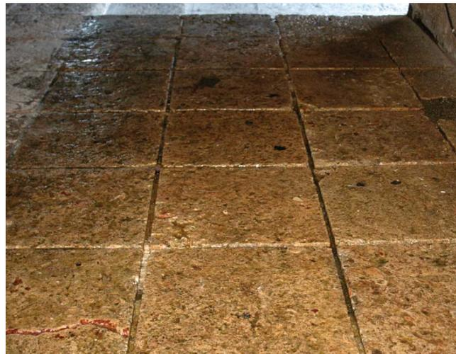
Detalle por contraste de una losa con y sin tratar con la resina epoxi transparente. Se puede notar como la grieta queda embebida bajo la resina ya endurecida aportando un efecto estético. En la foto a la derecha: La aplicación general en área seleccionada.
